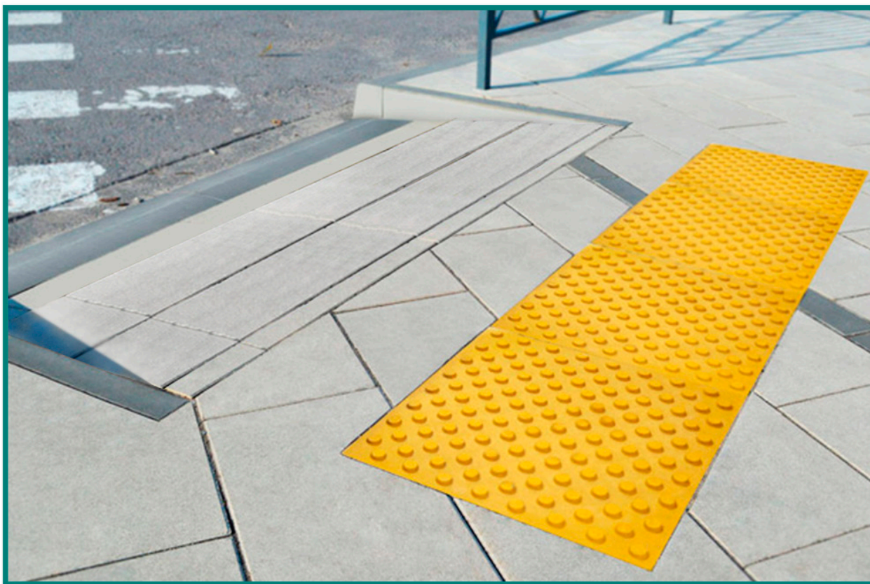
6- rasm. Ko'zi ojiz bolalar (shaxslar) uchun umumta'lim muassasasi hovlisining yo'laklariga o'rnatilgan taktil plitkalar
